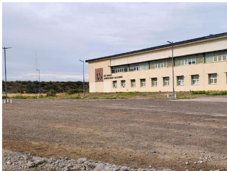
Imagen. Iluminación Estacionamiento de Campus Sede Atlántica.
