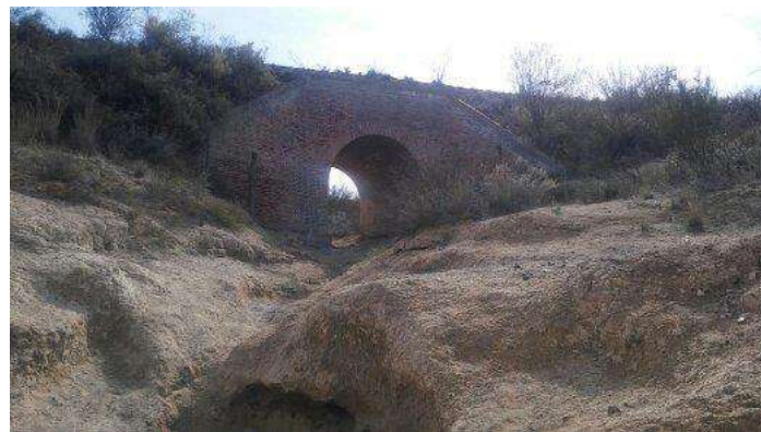
Imagen 4. Zona de bardas puentes y vías del ferrocarril próximos al río en la zona de Cerrito de Piedra en Chichinales. Agosto 2018
