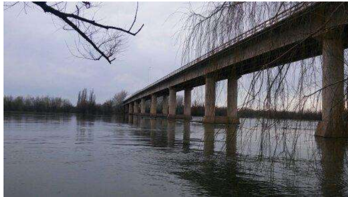
Imagen 27. Puente sobre el río Negro en General Conesa. Agosto 2018
